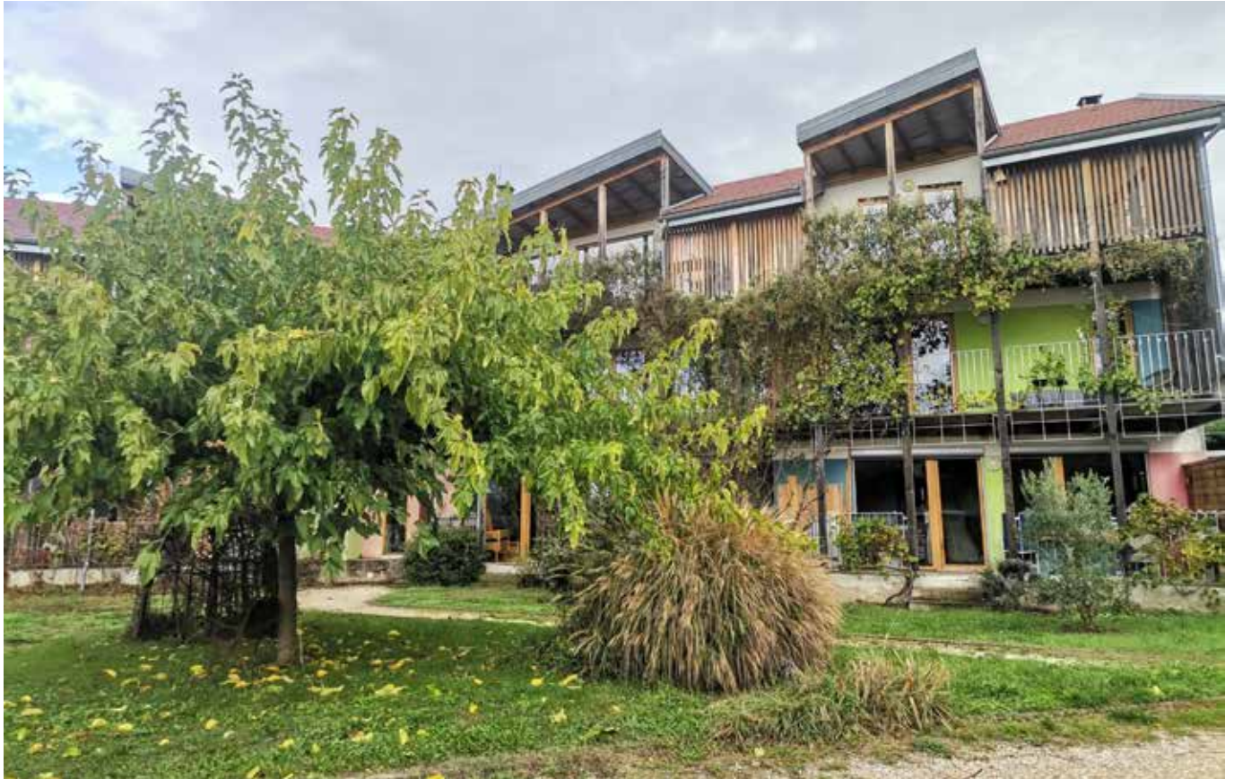
Opération d'habitat groupé « Les granges des Toits liés » à Pontcharra : projet d'habitat participatif de 8 logements intermédiaires datant de 2013. La programmation comprend également une salle commune, des chambres d'amis, un atelier de bricolage. Construction neuve (exceptés pour les espaces communs développés dans une ancienne grange réhabilitée), développée en autopromotion par plusieurs familles et avec une mixité de profils (âge, statut d'occupation) © AURG
