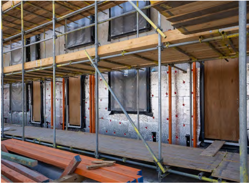
⇒ Isolation extérieure d'un bâtiment d'habitation © Éric Mclean
