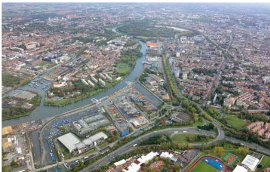
Vue aérienne du port fluvial de Lille.
