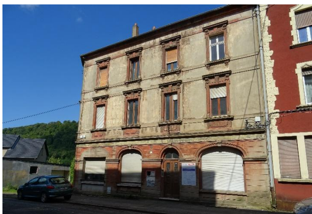
Création de 30 logements Batigère à Algrange
