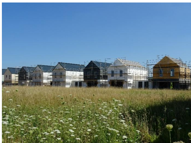
Logements commencés, rue d'Uckange à Fameck
