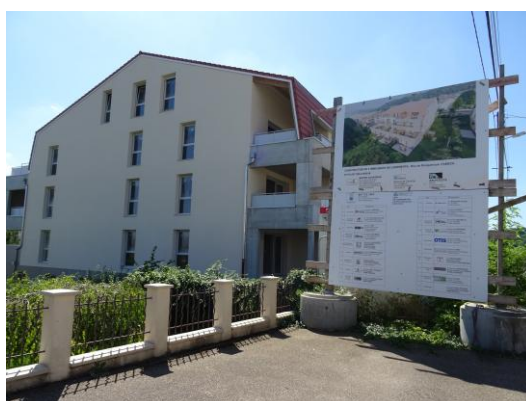
110 logements rue de Ranguevaux à Fameck
