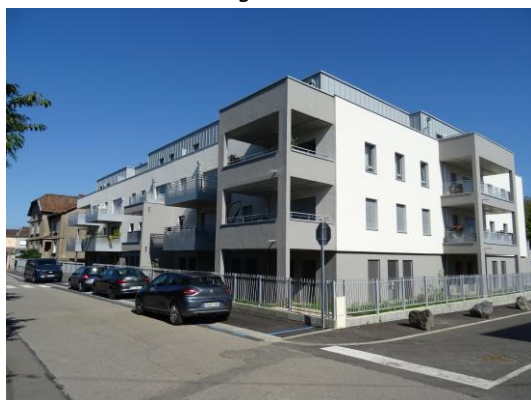
Rue de l'Ancienne Poste à Uckange
