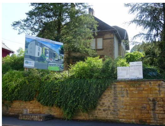
46 logements, rue Foch à Algrange
