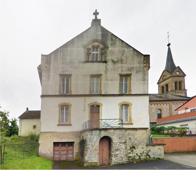
**EN CHANTIER** - la pierre de Jaumont est nettoyée, les enduits à la chaux repris, en attente des nouvelles ferronneries
