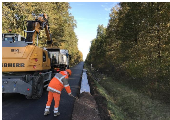
Figure 4 : Exemple d'étanchéification d'une route. Source : CEREMA.
