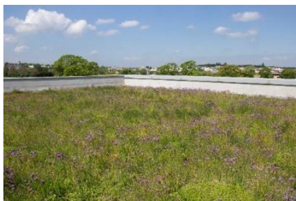
Toiture végétalisée d'un bâtiment tertiaire à Metz. ©AGURAM
