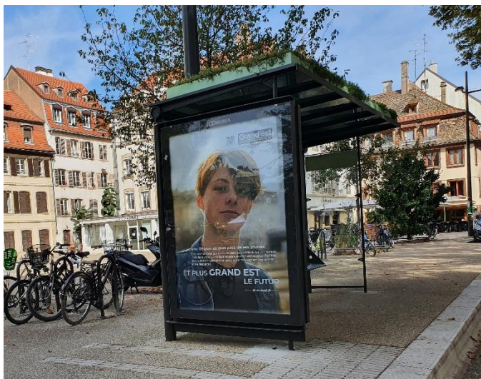
Toiture d'abri de bus végétalisée à Strasbourg. ©AGURAM
