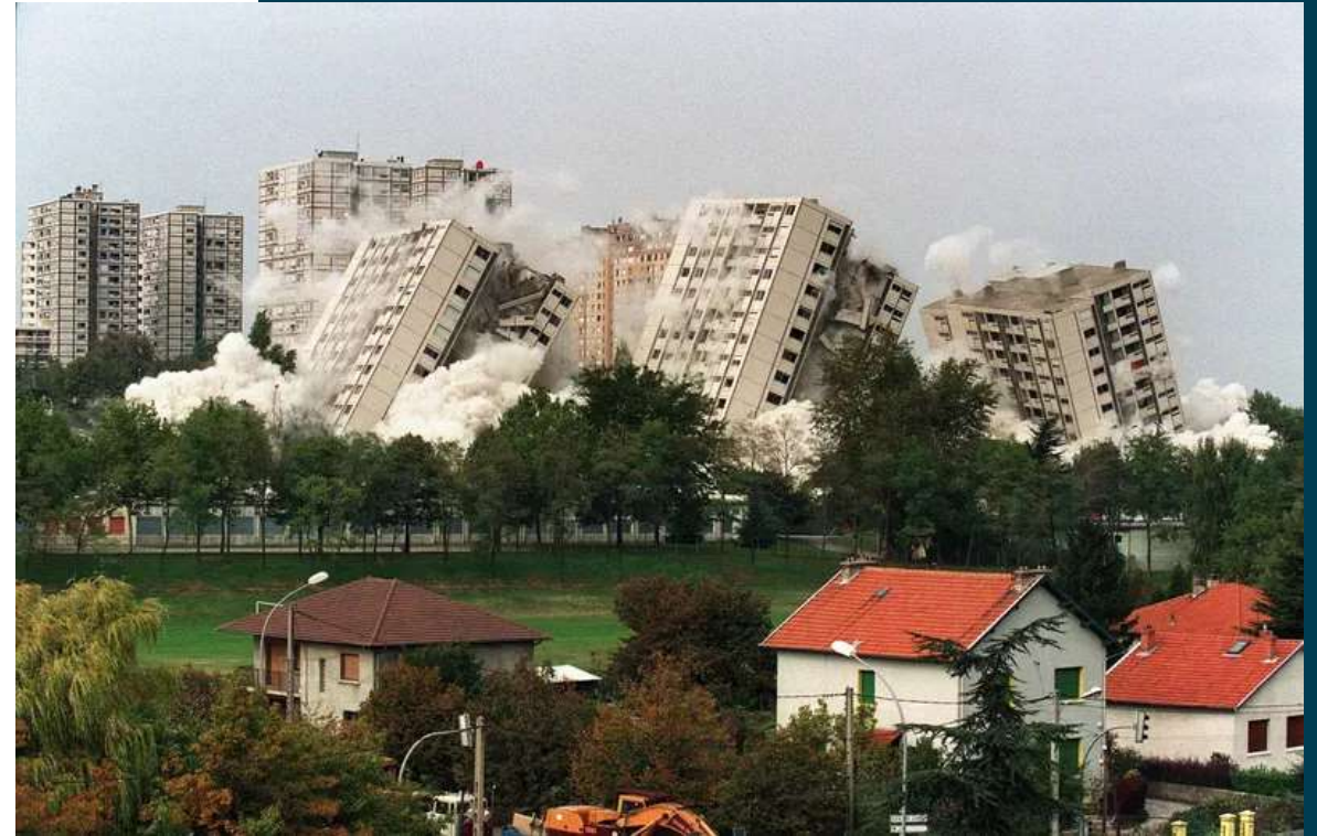
Démolition de 6 tours à Vénissieux en 1994. Le Figaro
