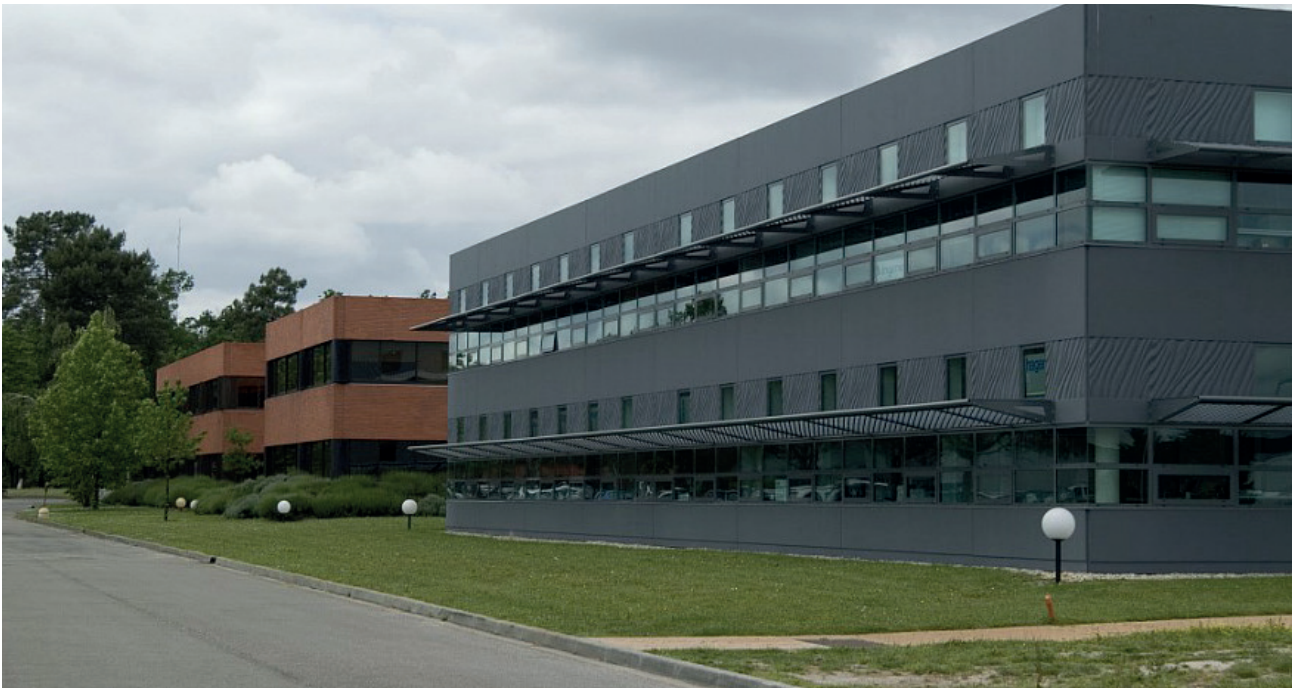
Immeuble tertiaire, Parc d'activité. Crédit Aurba
