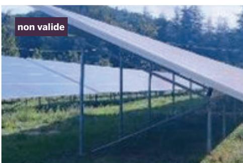
Ancrage au sol de type pieux métallique a priori réversible, pas de possibilité de vérifier s'il y a un scellement béton.
