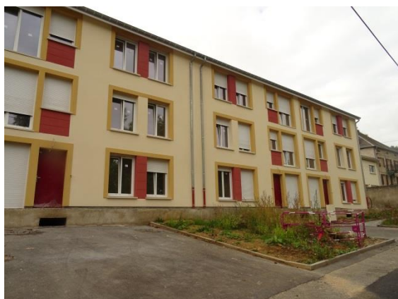
Serémange-Erzange, 8 logements locatifs sociaux LOGIEST dans la rue du Général de Gaulle
