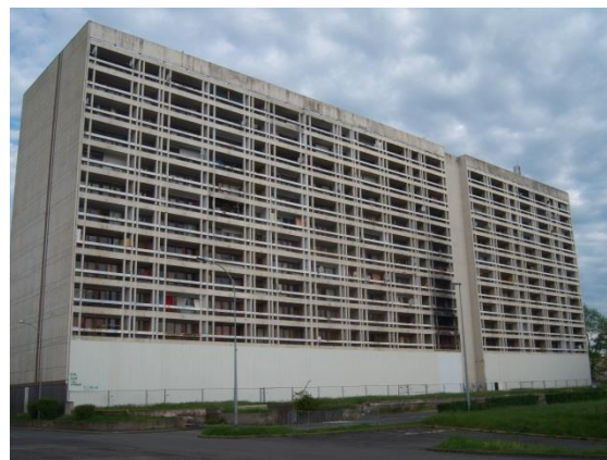
Copropriétés des Tilleuls, avant démolition, après l'incendie, Source : CA Val de Fensch
