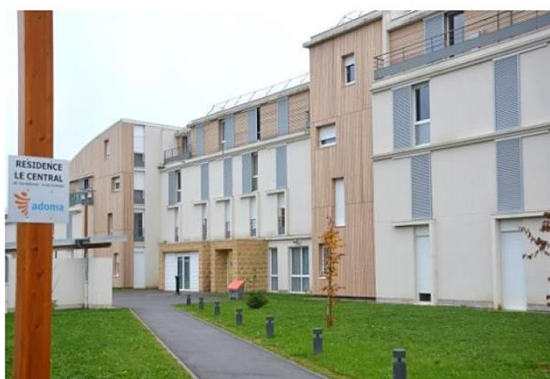
Résidence sociale Le Central à Florange de 80 logements par ADOMA, Source : CA Val de Fensch
