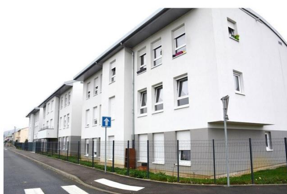
Démolition de l'ancien FTM à Fameck et reconstruction d'une résidence sociale de 49 logements par Présence Habitat, Source : CA Val de Fensch
