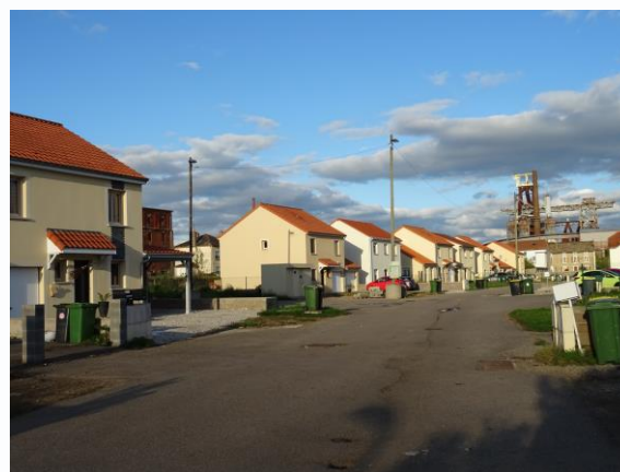
Lotissement Rue Jean Jaurès, Uckange
