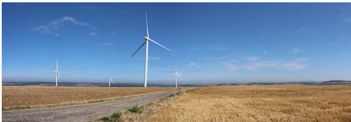
Parc éolien près de Boulay
