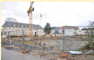
Actions de redynamisation du centre-ville de Châlons, la requalification du quartier de l'abbaye de Toussaint.
