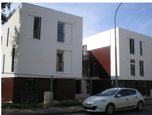
Logements sociaux MHT à Metz-Queuleu (2013)
