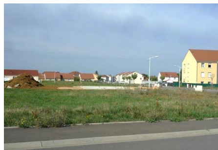
9 maisons individuelles, rue Raymond Mondon à Roncourt, AGURAM
