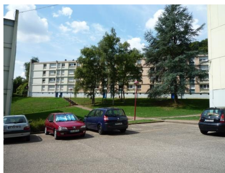
Logements collectifs Moselis, rue des Essards, Rosselange, AGURAM
