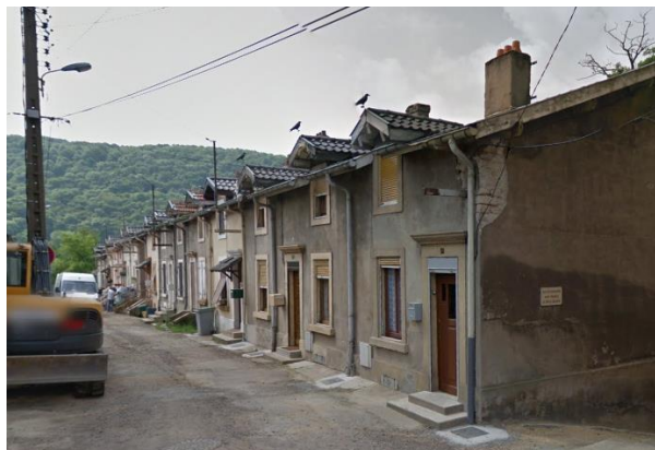
Impasse Fabert avant travaux en mai 2012, Source : Google Maps
