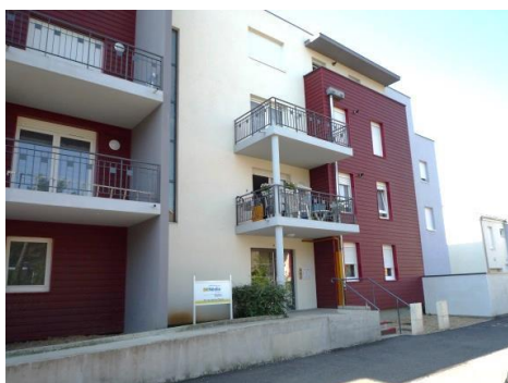
Logements collectifs Néolia, rue de la gare, Moyeuvre-Grande, AGURAM
