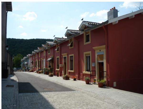
Impasse Fabert après travaux, en août 2015, AGURAM
