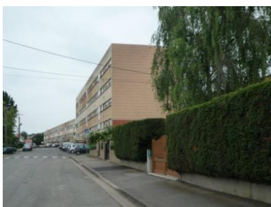
Logements collectifs, Rombas Source : AGURAM
