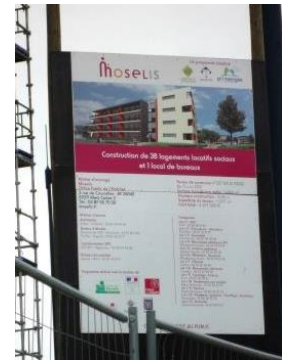
Construction de logements sociaux, Moselis, Rombas
