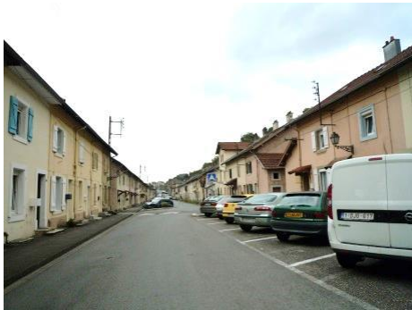
Logements individuels, Rosselange
