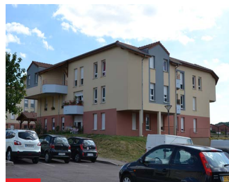
Opération Moselis: Résidence Gaia, rue des Romains.
