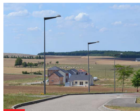
Lotissement en cours, rue la Crobière.
