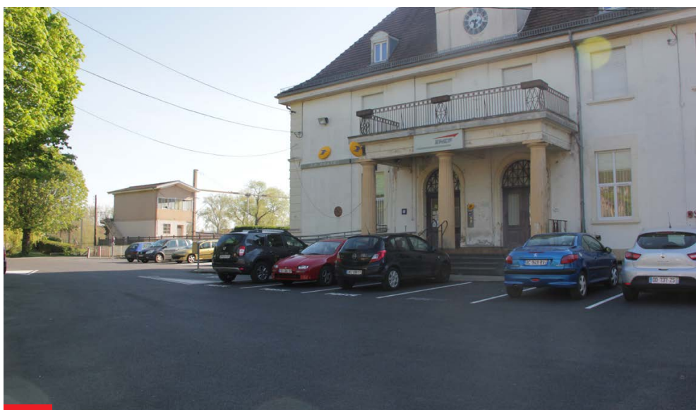
Le parking gare, bien aménagé, est cependant d'une capacité parfois insuffisante – Doc. Aguram
